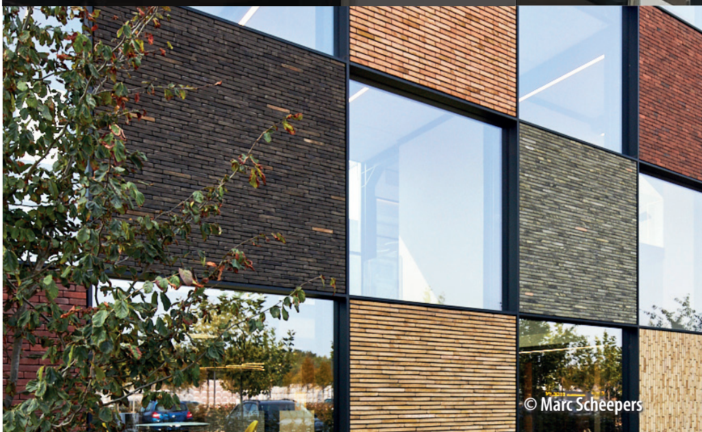
In totaal werden 128 demovlakken voorzien van gevelstenen en kleiklinkers aan zowel de binnen- als de buitenkant van het gebouw.
